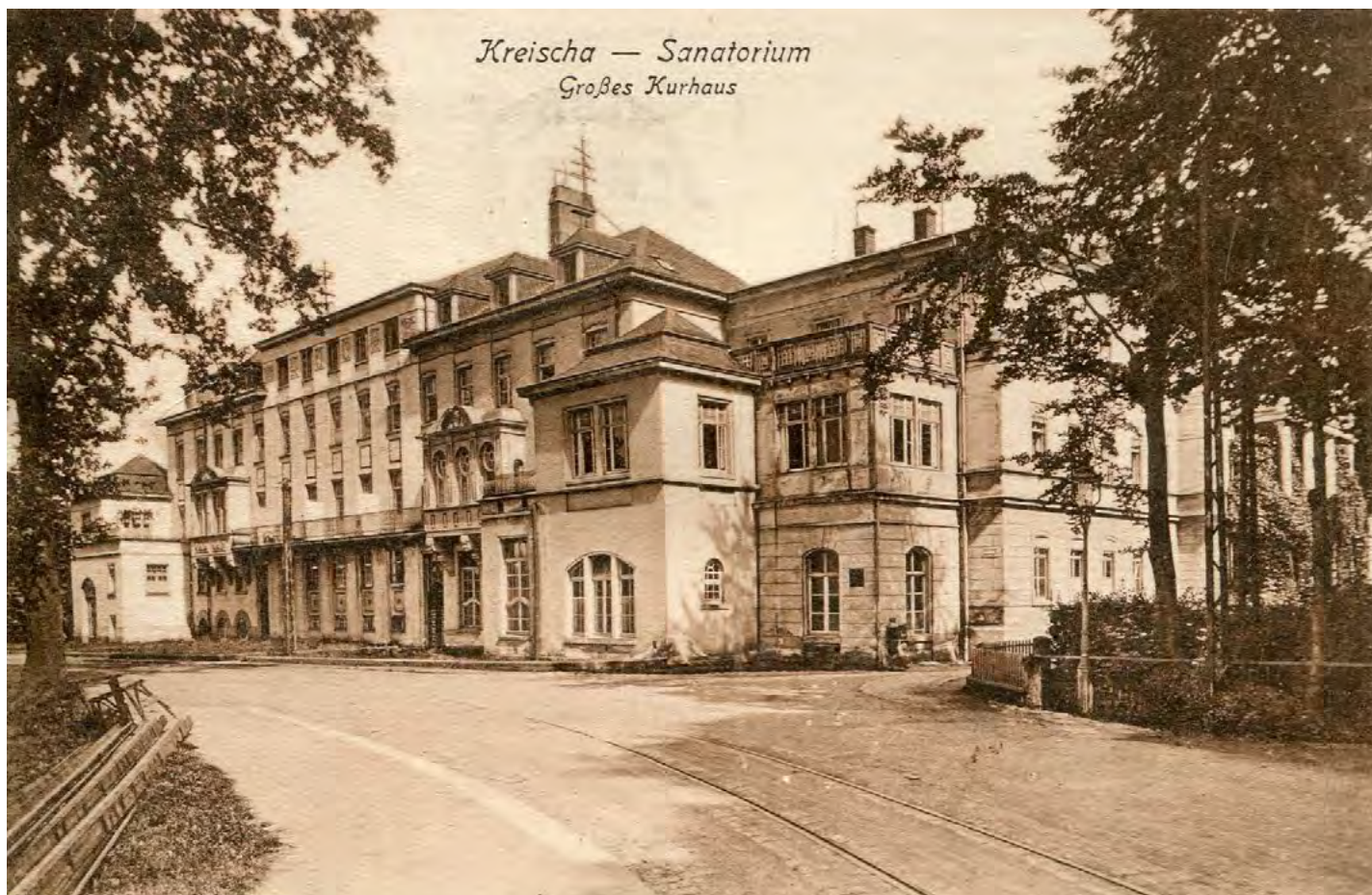
Das Große Kurhaus war lange das Hauptgebäude der zahlreichen Kur- und Klinikgebäude. Seit Jahren ungenutzt, ist es heute dem Verfall preisgegeben.
